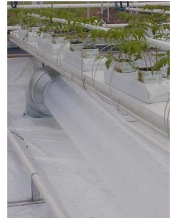
Distribution en surface par des gaines perforées placées sous les gouttières de culture
