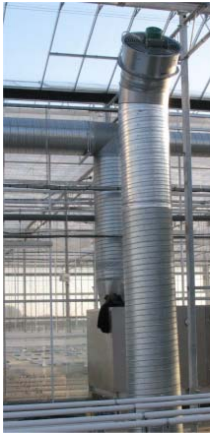
Aspiration de l'air en partie haute de la serre (ventilateur et gaine)
